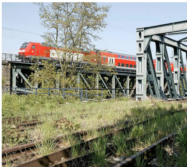
Die Baukosten für den 3,1 Kilometer langen Streckenabschnitt übernimmt grösstenteils Deutschland. Foto: Roland Schmid
